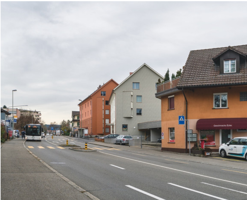
Die Zürichstrasse zerteilt das Zentrum von Brüttisellen. Das rote und das helle Haus gehören zur Überbauung.
